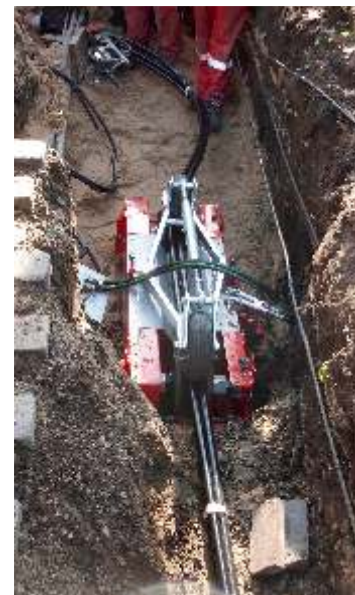
Verlegung von 3 x Einleiterkabeln 30 kV
